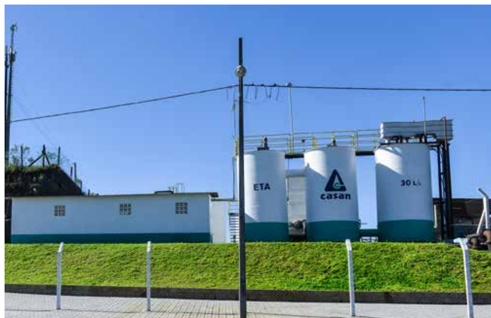
A Estação de Tratamento de Água (ETA) Compacta em Cunha Porã, com capacidade de 30 litros por segundo, reforçou o Sistema de Abastecimento do município, beneficiando mais de sete mil moradores da área urbana
