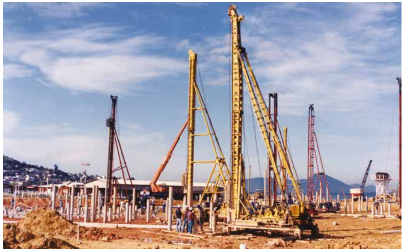
As obras de fundação da Estação de Tratamento de Esgoto Insular em Florianópolis receberam, no total, 48 quilômetros de estacas
