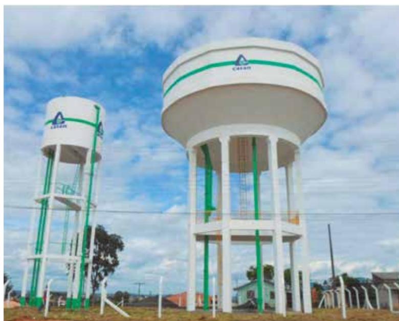
Em Canoinhas, a instalação recente de um reservatório elevado com capacidade de 500 metros cúbicos e a implantação de uma nova adutora de água tratada beneficiam quatro importantes bairros do município
