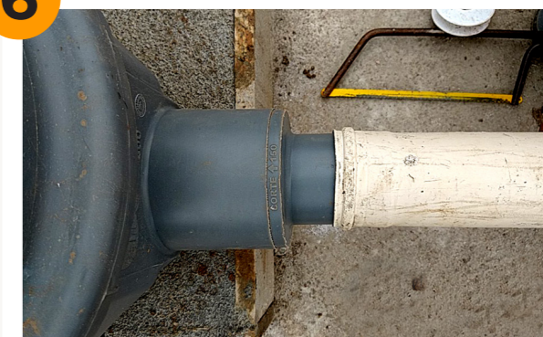
Conexão da tubulação residencial à Caixa de Inspeção.
