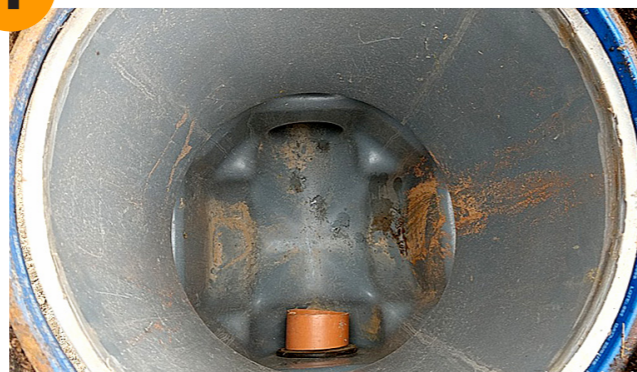
Vista interna da Caixa de Inspeção.
