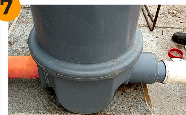
Conexão finalizada. Tubulação alaranjada é a da rede coletora da CASAN e a branca vem da casa do morador.
