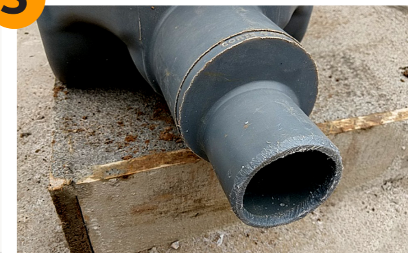
Caixa de Inspeção pronta para receber tubulação residencial.
