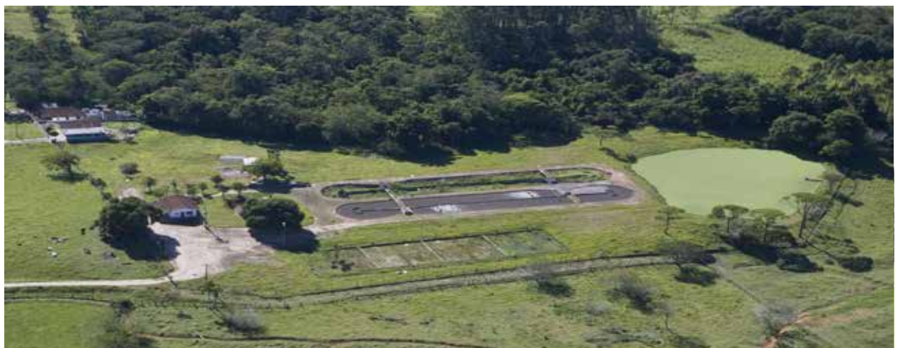
ETE - ESTAÇÃO DE TRATAMENTO DE ESGOTO - SANTO AMARO DA IMPERATRIZ
