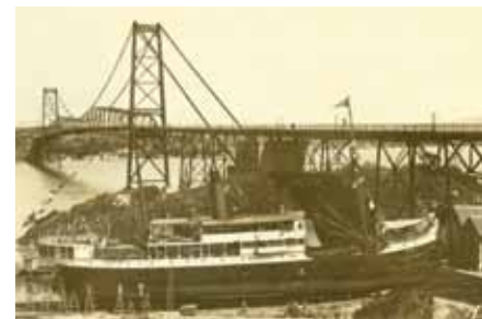
Capa: Florianópolis, década de 1920 – vapor Anna puxado na “carreira” do Estaleiro Arataca, procedimento que era realizado periodicamente para manutenção das embarcações da frota da Empresa Nacional de Navegação Hoepcke. Foto: Centro de Memória – Instituto Carl Hoepcke.
