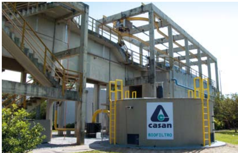
Estação de Tratamento de Esgotos Insular, em Florianópolis: investimento em sistema de filtragem para o controle de gases
