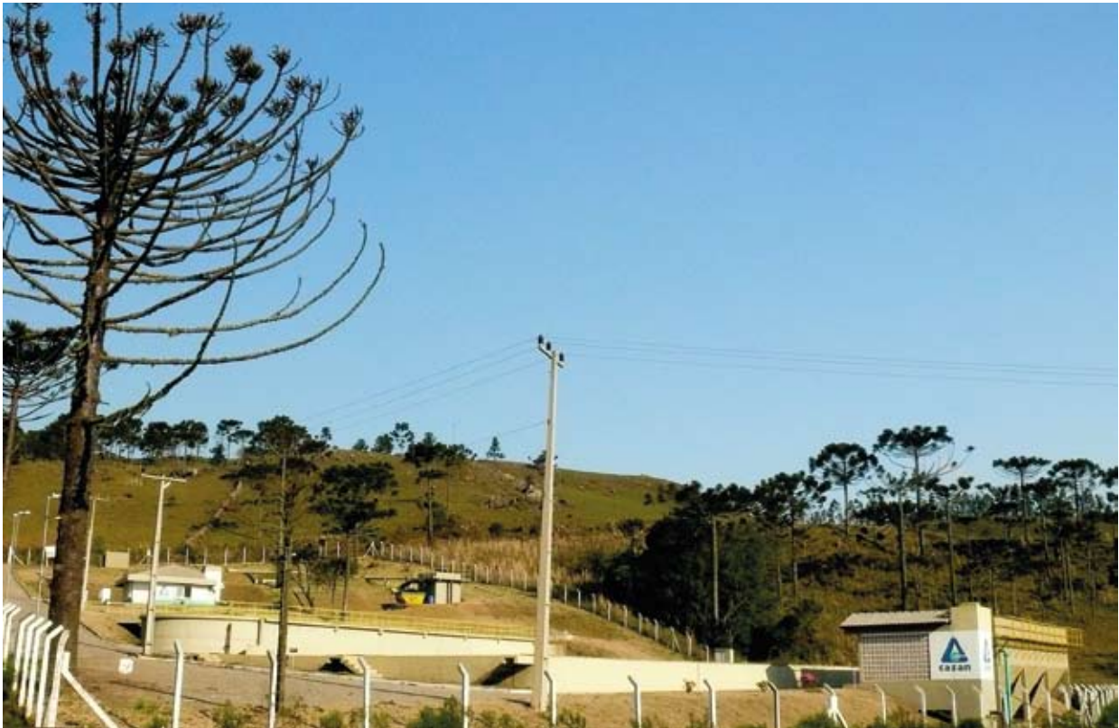
Estação de Tratamento de Esgotos de São Joaquim, na Serra catarinense: CASAN administra 37 sistemas de esgotamento sanitário, com 50.666 ligações São Joaquim Sewage Treatment Station, in the Serra Catarinense: CASAN administers 37 Sanitary Sewage Systems with 50,666 connections
