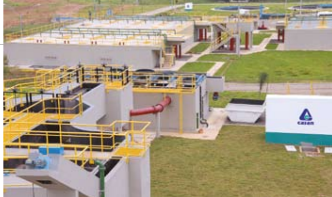
Estação de Tratamento de Esgotos em Criciúma: obra concluída em benefício da população do Sul catarinense
