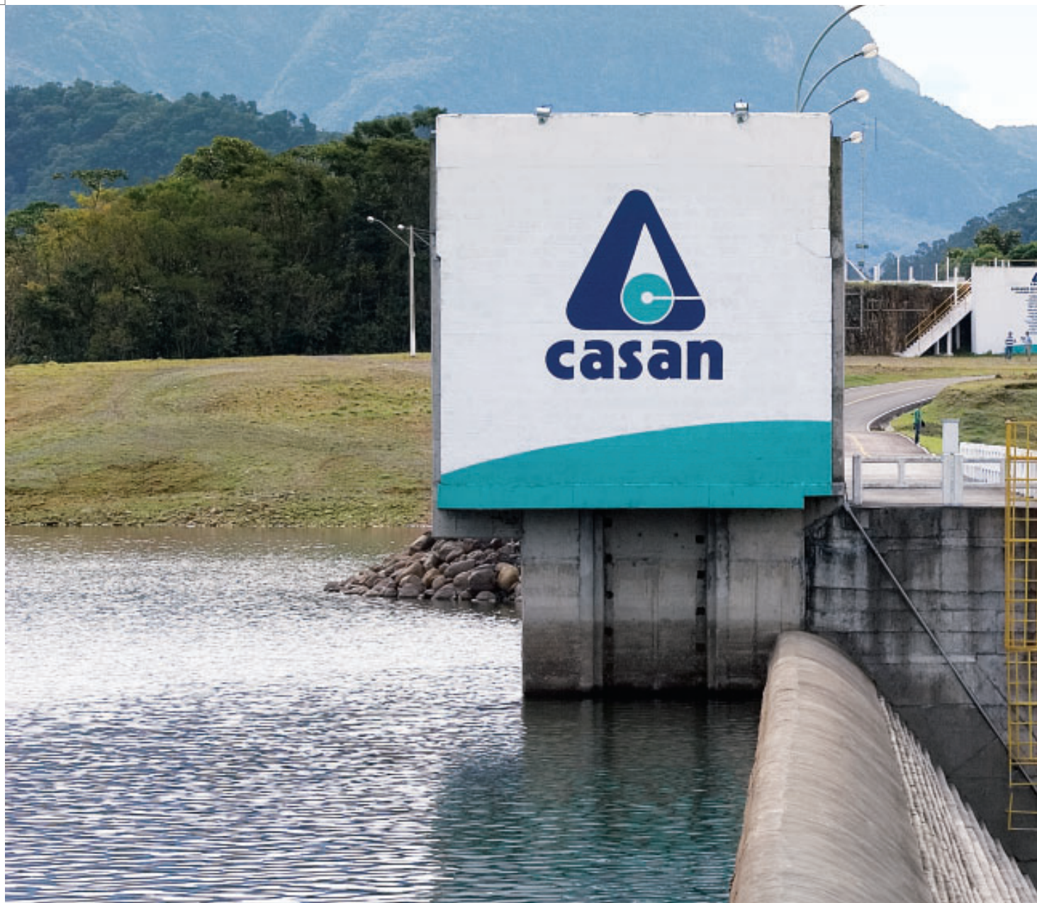
Barragem do Rio São Bento, no município de Siderópolis, obra concluída em 2006.
