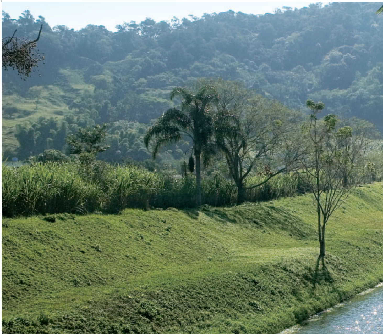
Captação no Rio Cubatão, no município de Santo Amaro da Imperatriz (SC).
