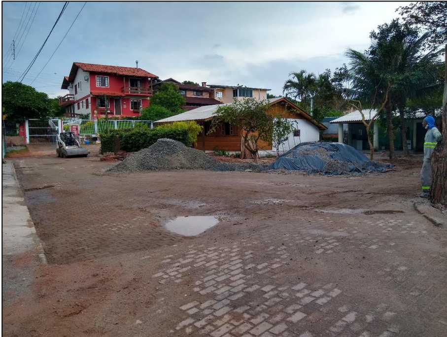
Figura 3 - Serv. Luiz Manoel Duarte recebendo material para recuperação de calçamento. Fonte: CASAN, 2021.
