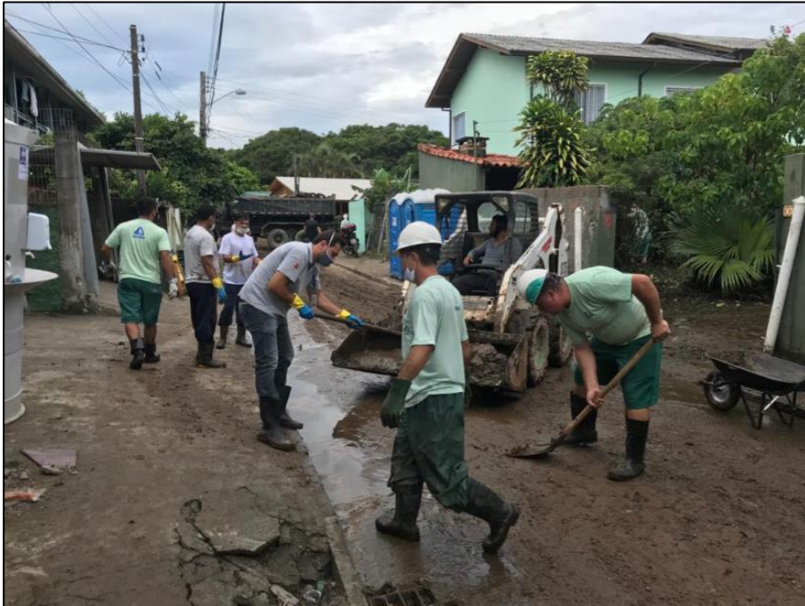
Figura 1 - Servidão Luiz Manoel Duarte - Ação de funcionários e retirada do material por bobcat. Fonte: CASAN, 2021.
