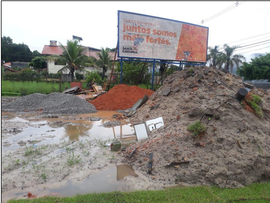
Figura 21 - Terreno da Av. das Rendeiras com material de base para recuperação. Fonte: CASAN, 2021.
