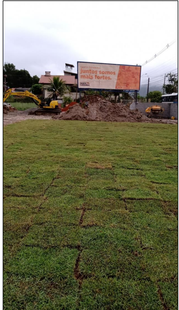
Figura 26 - Terreno da Av. das Rendeiras com material. Fonte: CASAN, 2021.
