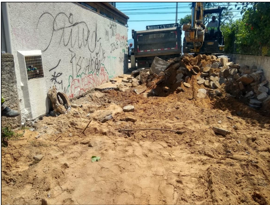
Figura 2 - Recuperação e limpeza do início da Serv. Luiz Manoel Duarte com maquinário. Fonte: CASAN, 2021.
