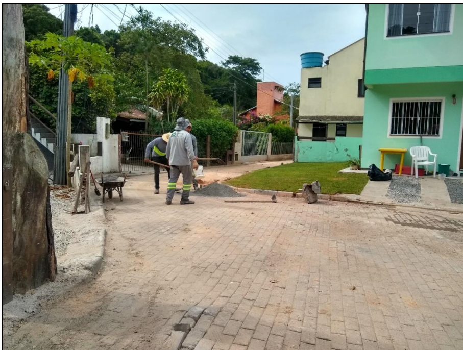
Figura 4 - Serv. Luiz Manoel Duarte com calçamento recuperado. Fonte: CASAN, 2021.
