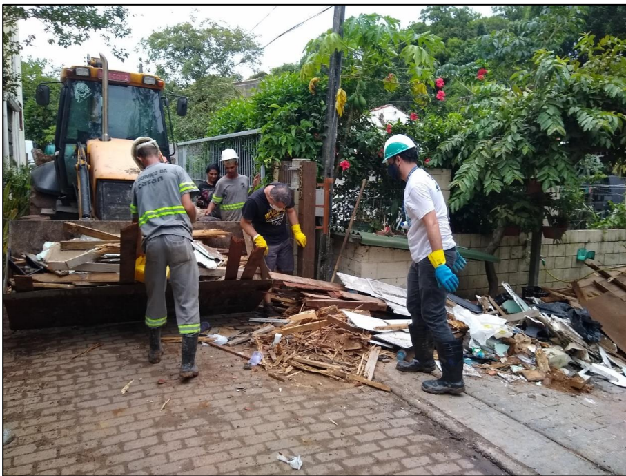
Figura 16 - Transporte de material acondicionado. Fonte: CASAN, 2021.
