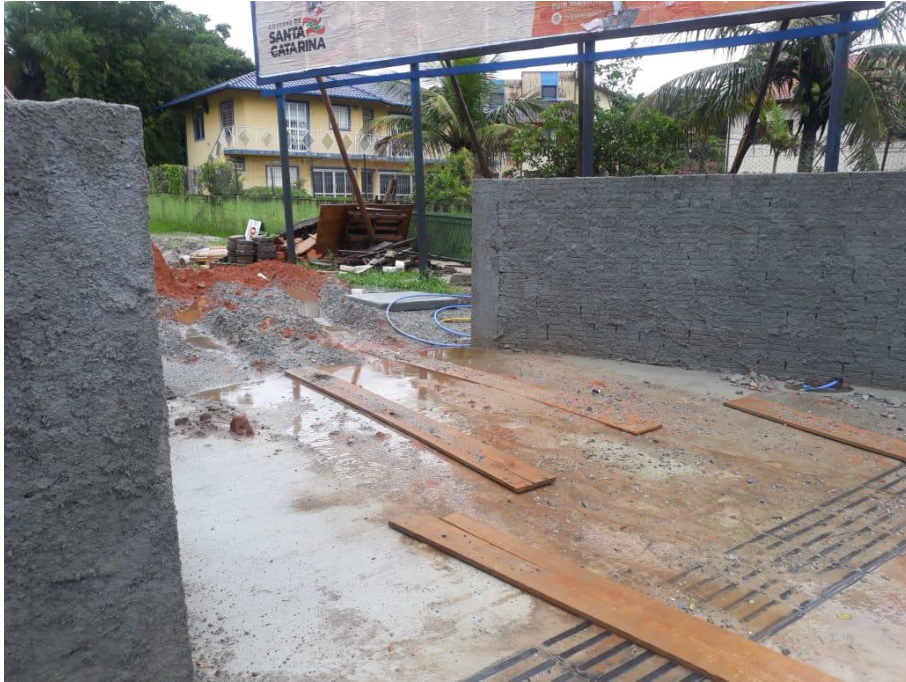
Figura 23 - Terreno Av. das Rendeiras em recuperação. Fonte: CASAN, 2021.
