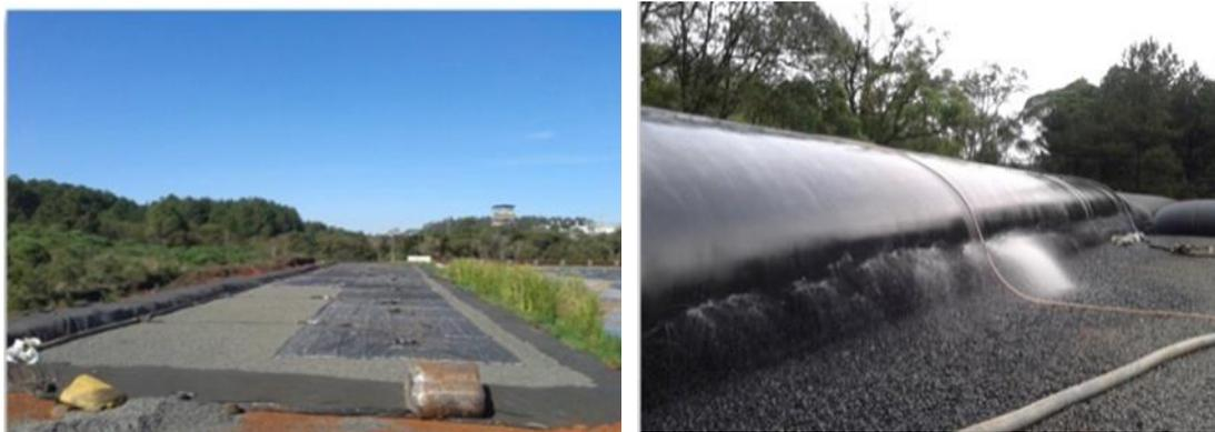
Figura 50 Ilustração do método de desaguamento do pacote lamoso-arenoso-arenoso
