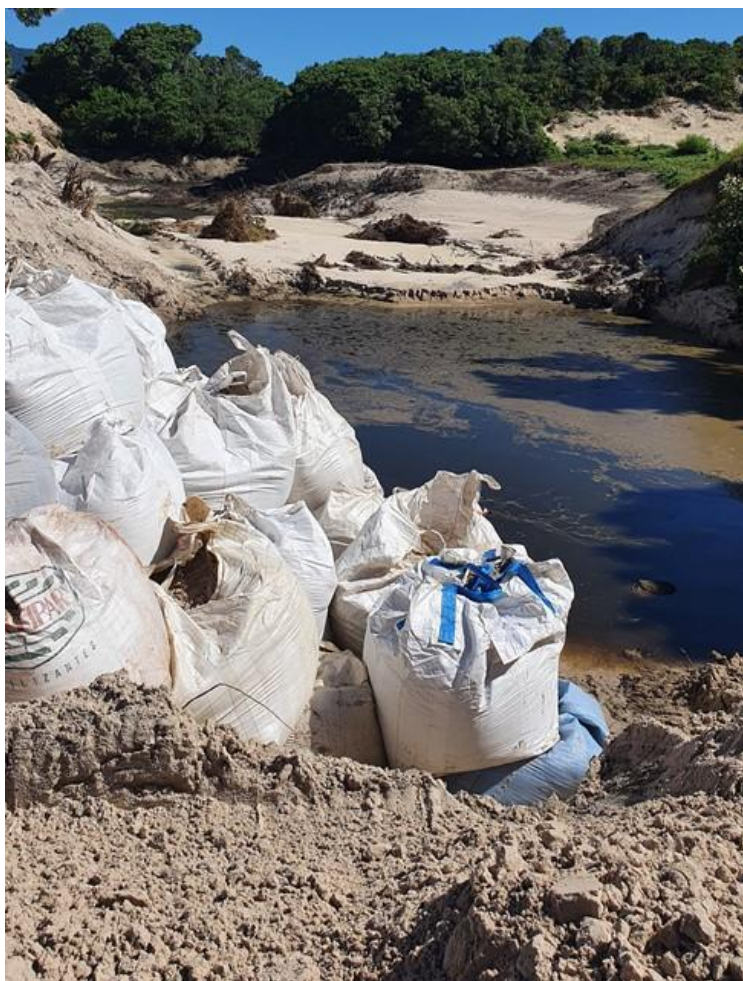
Figura 43 Detalhe sacos de areia utilizados para a contenção intermediária
