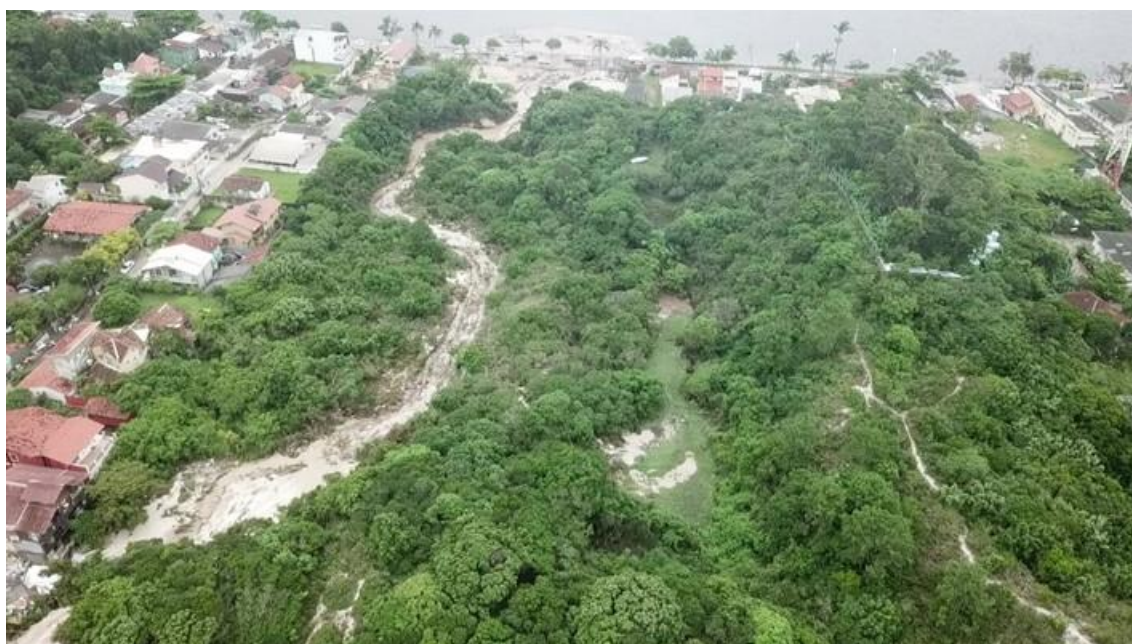
Figura 42 Acesso aberto para escoamento da água e entrada do maquinário na área E
