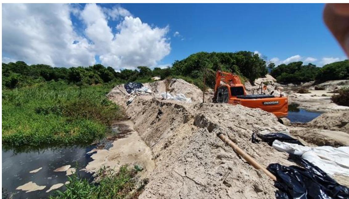
Figura 41 Contenção intermediária entre as áreas A e B
