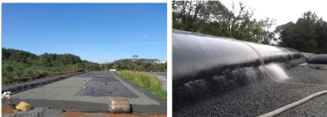
Figura 50 Ilustração do método de desaguamento do pacote lamoso-arenoso-arenoso
