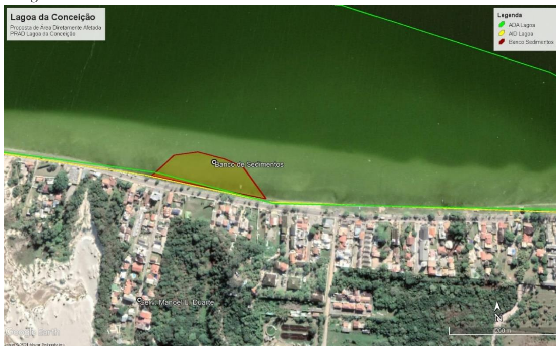
Figura 25 Detalhe do banco de sedimentos formado próximo à Av. das Rendeiras
