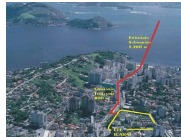
Novo SDO Icaraí em Niterói – emissário de 3.300 m dentro da Baía de Guanabara para uma vazão de 0,95 m 3 /s de esgoto
