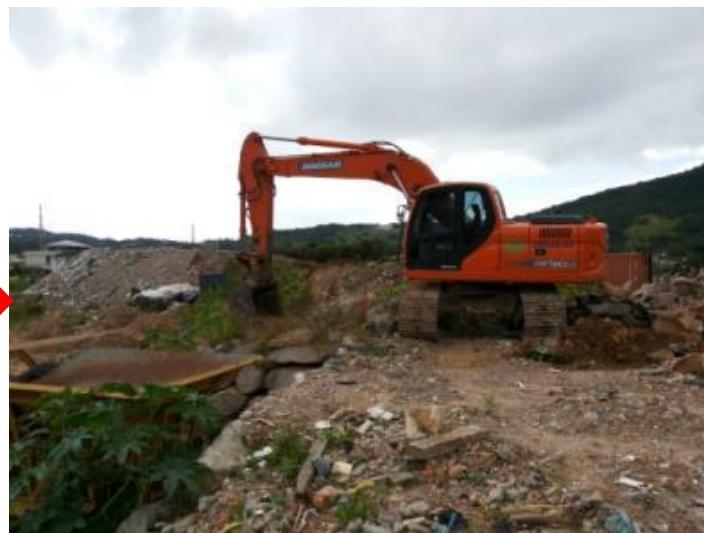
O LIXO DA CONSTRUÇÃO CIVIL É TRIADO EM UNIDADE DE RECICLAGEM E SEPARADO MECANICAMENTE E ENCAMINHADO A CENTRAL DE BRITAGEM
