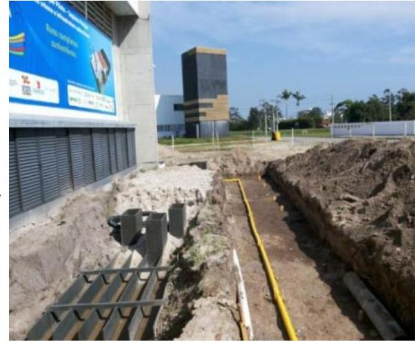
MONTAGEM DE REDE DE ESGOTO, GASODUTO DE ALTA PRESSÃO E SISTEMA DE DRENAGEM
