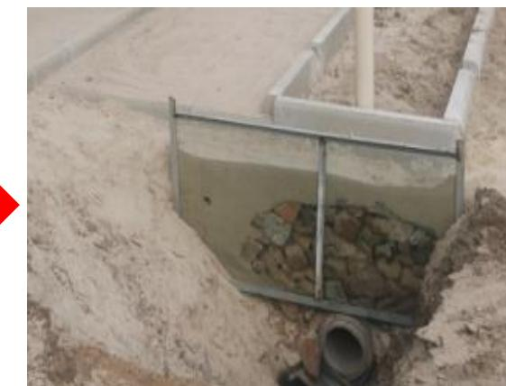
USO DE BRITA (CAPA DRENANTE DO SISTEMA DE CAPTAÇÃO PLUVIAL) E AREIA NA CICLOVIA
