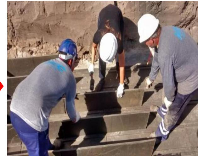
MONTAGEM DOS PAINÉIS PAREDE DE PLÁSTICO RECICLADO
