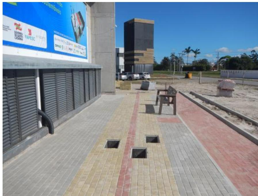
SISTEMA INFRASIA SINALIZADO COM BLOCOS EM CORES DIFERENCIADAS LOCALIZANDO O LOCAL EXATO DAS REDES
