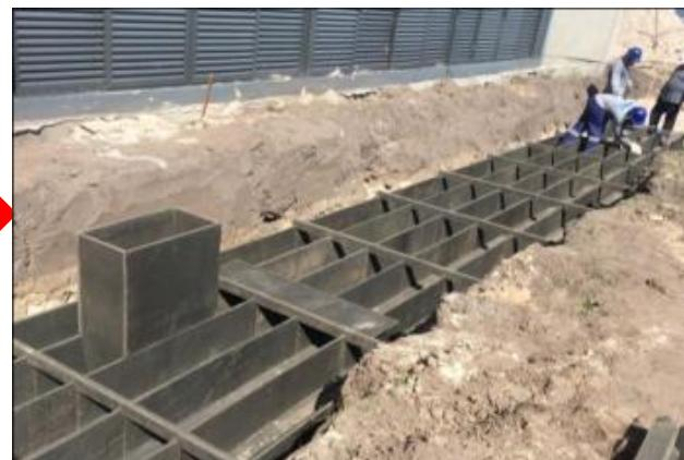
IMPLANTAÇÃO DAS PLACAS DE PLÁSTICO RECICLADO DO SISTEMA INFRAVIAS
